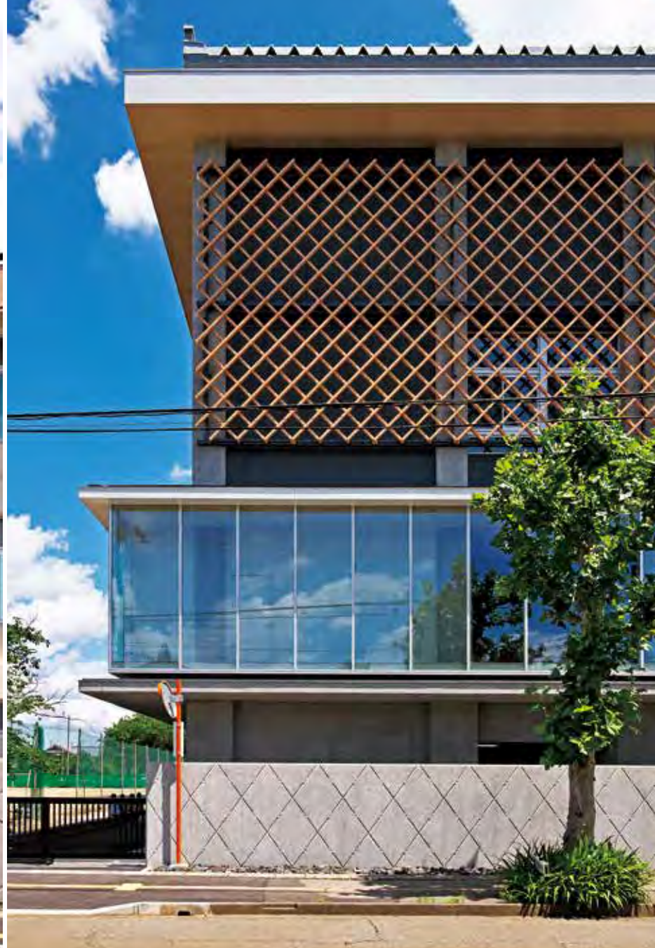
体育館外観ディテール
