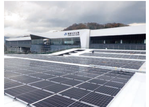
屋根工事状況
