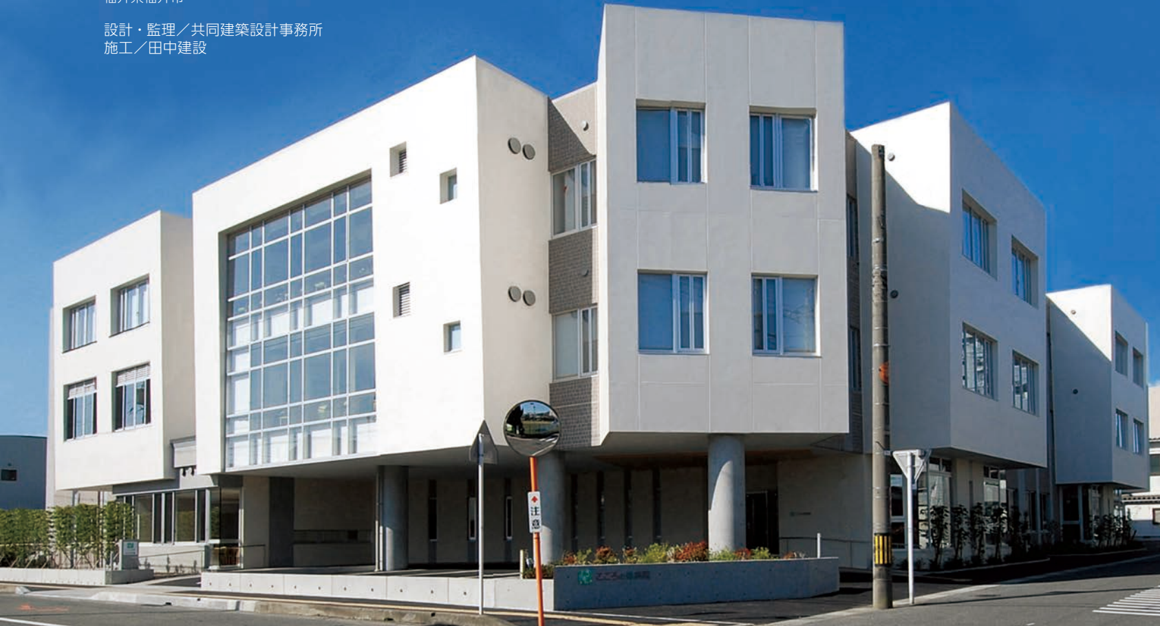
北東外観 分節しボリュームを抑えつつ、跳ね出した病室が印象的なファサード
