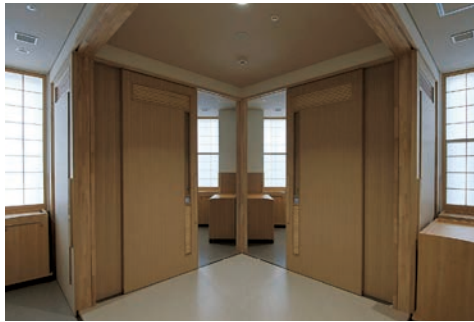
個室型4床室 各ベッドを建具で仕切り個室に近い空間とすることができ
