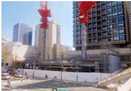
PCa建方開始状況
